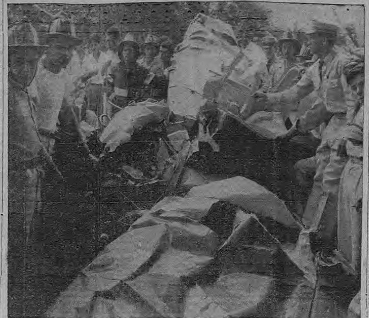
Aluminio retorcido y piezas de acero en masa informe. Así quedó la avioneta TI-254 al estrellarse en el patio de la residencia de don Amparo de Zeledón, en el costado norte de La Sabana.
